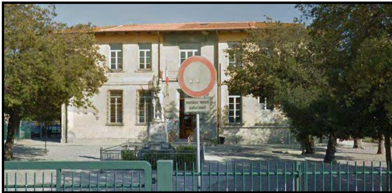
Figura 7. Vista della facciata d'ingresso principale dell'edificio "San Giovanni Bosco".
