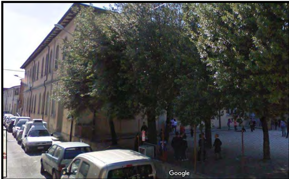
Figura 3. Vista delle facciate poste a nord ed est dell'edificio scolastico "Galilei Galileo".
