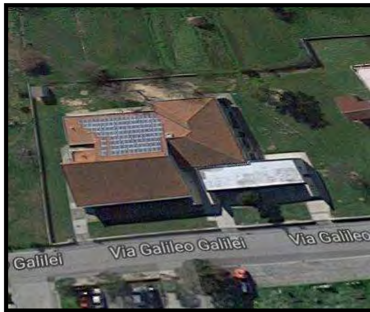
Figura 6. Vista dall'alto dell'edificio scolastico "Ciari".
