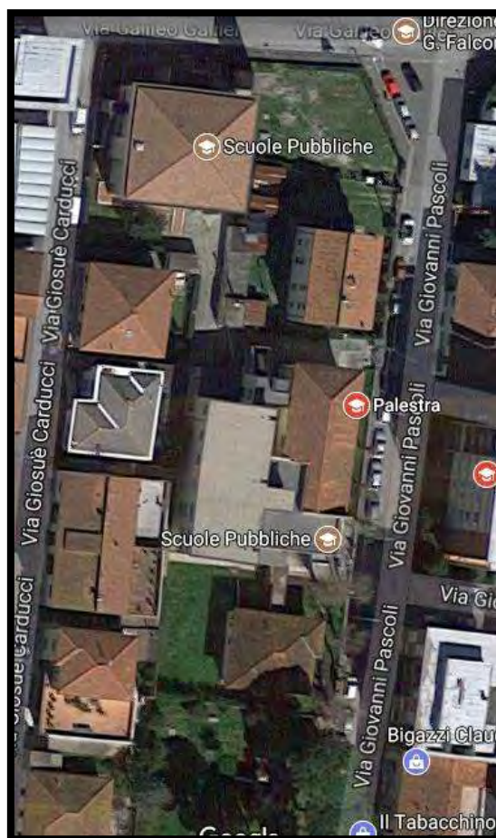
Figura 10. Vista dall'alto dell'edificio scolastico "Giovanni Pascoli".
